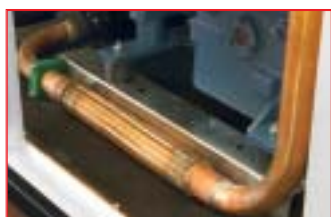
Anaconda on the discharge Anaconda auf der Druckseite
