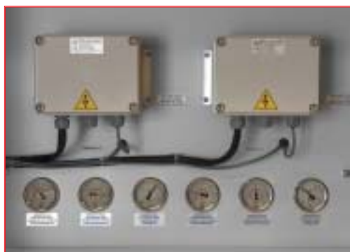
Speed regulators (one per circuit) Ventilator Drehzahlregelung (separat je Kältekreis)
