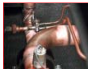
Liquid injection detail compressor Einspritzeinrichtung des Kompressors
