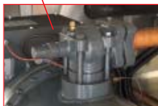
Suction and discharge shut off valve Saug- und druckseitige Absperrventile
